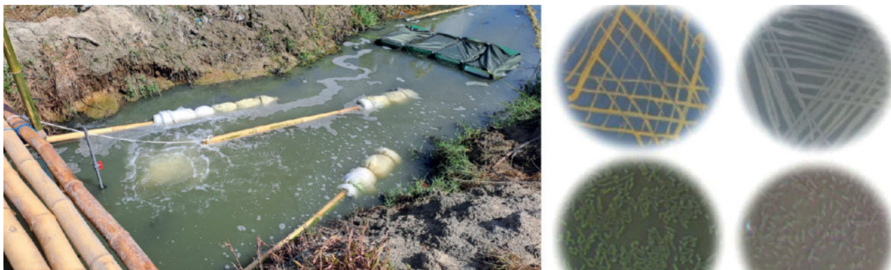
Фото 7.3. Фрагмент очистных сооружений с разными видами биоактивных бонов (слева), заселенных клетками консорциума (справа)
